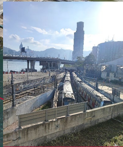
運行中的露天列車軌道 EXPOSED OPERATING RAIL TRACKS
